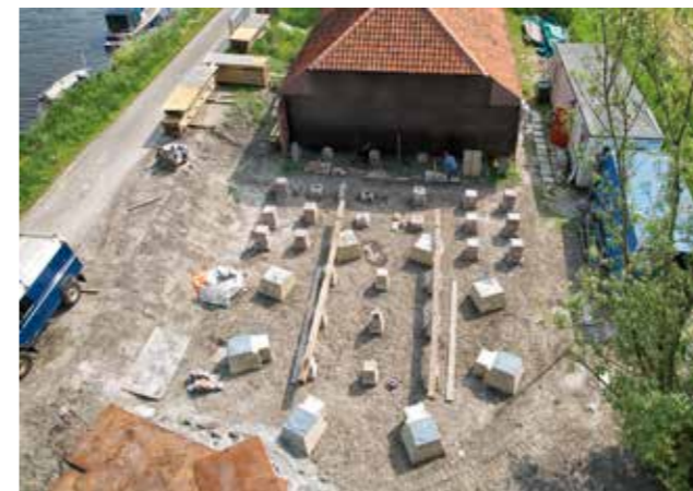
De poeren voor molen en aanbouwen zijn opgemetseld, de romp van de molen kan erop worden geplaatst. (© foto Wim Giebels)
